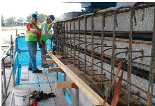
Figura 3: Refuerzo estructural mediante postesado exterior.
