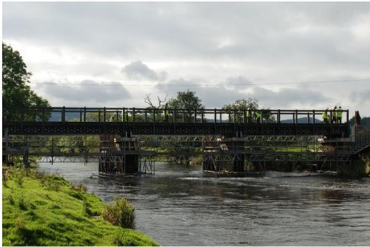
Figura 2: Puente de plástico reciclado construido por la empresa Veritech en Gales (Reino Unido).
