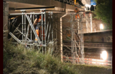
Reparación P.S. Combe (Suiza)
