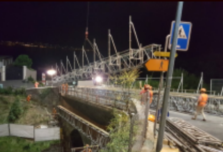
Ampliación puente Brélaz (Suiza)
