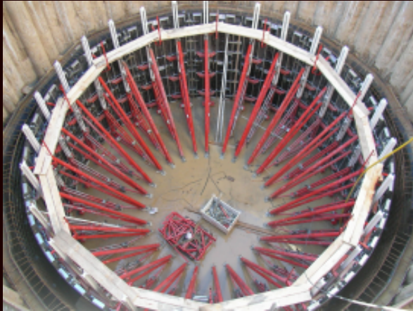
Pozo de ataque hinca colector de la Reguera (Móstoles)
