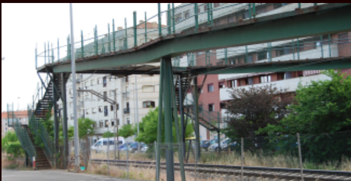
Reparación de pasarela sobre la línea Bilbao-Castejón en Logroño
