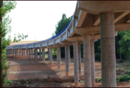
Viaducto y pasos superiores variante Ayllón (Soria)
