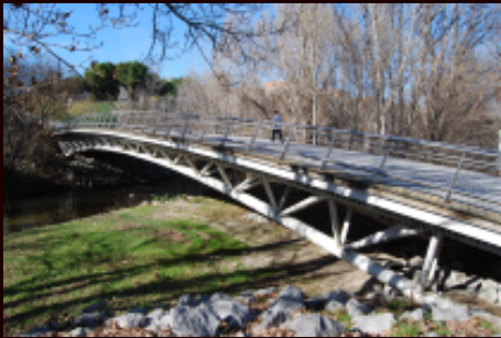
Cimentación pasarela Mezquita (Madrid)
