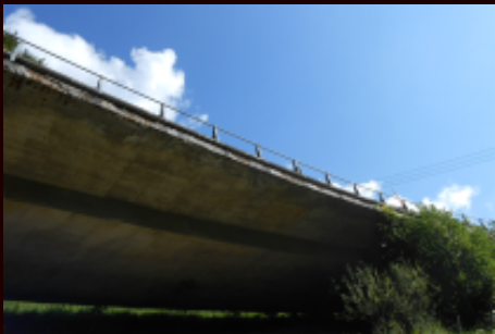
Reparación puente Champillon (Suiza)
