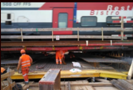
Paso inferior estación de Gland (Suiza)
