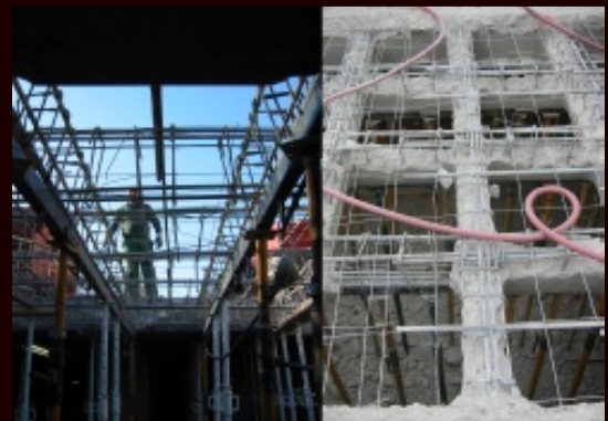
Rehabilitación parking Vía Complutense (Alcalá de Henares)
