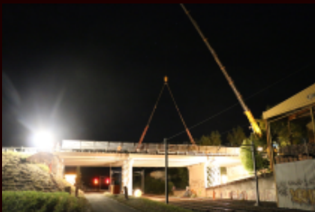
Reparación P.S. Combe (Suiza)
